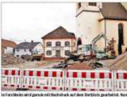
In Forchheim wird gerade mit Nachdruck auf dem Dorfplatz gearbeitet. Nun hat der Gemeinderat weitere Arbeiten beschlossen.
